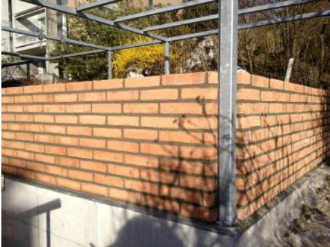
Sichtmauerwerk wie bestehende Siedlung
