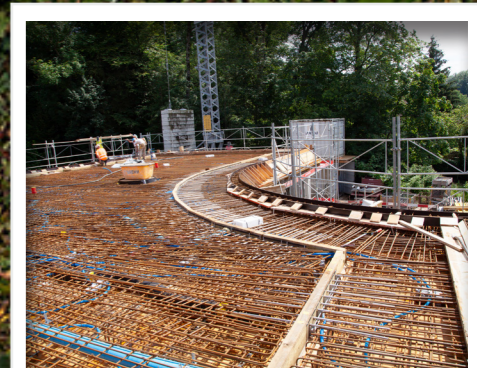
Schalung & Armierung Decke
