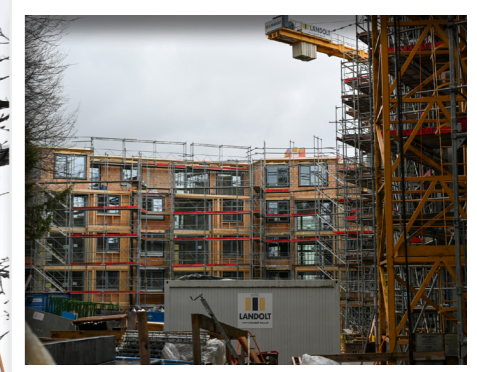
Rückseite der Baustelle
