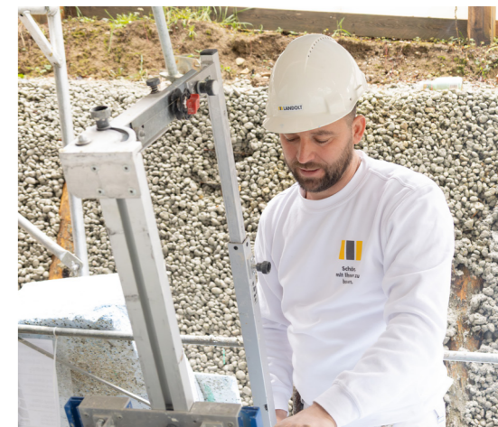
Am Dämmung schneiden
