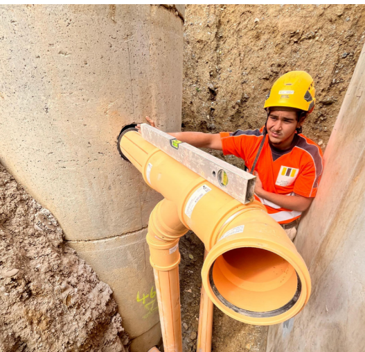
Kanalisation mit Ueli
