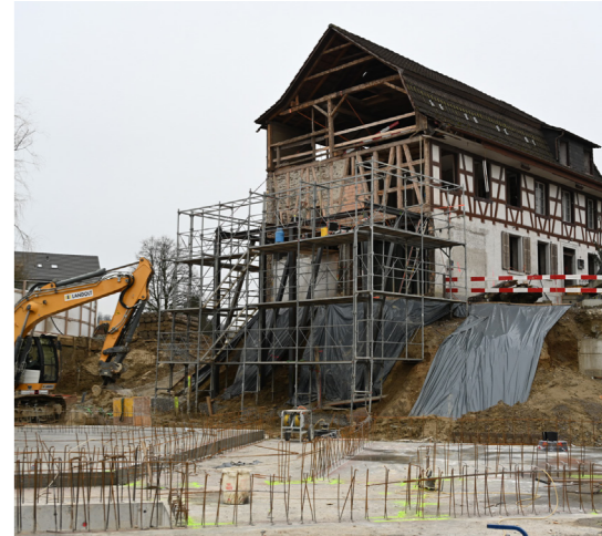
Unterfangung mit Stahlträgern
