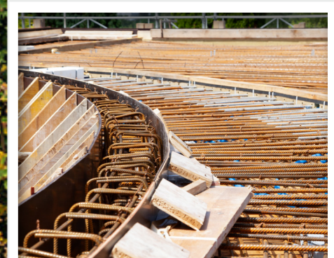
Schalung & Armierung Decke
