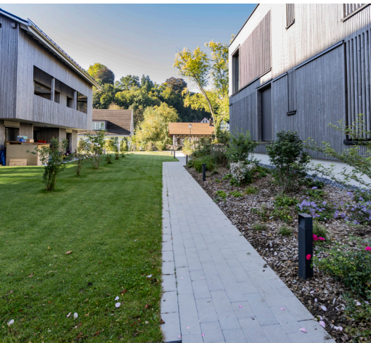
Hauptsitz - zwischen Annexbau und Wohnungen
